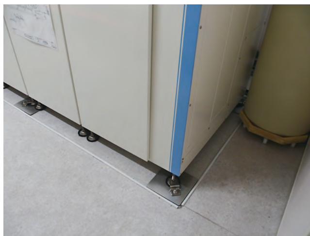
図3 透析液供給装置、RO装置の固定
