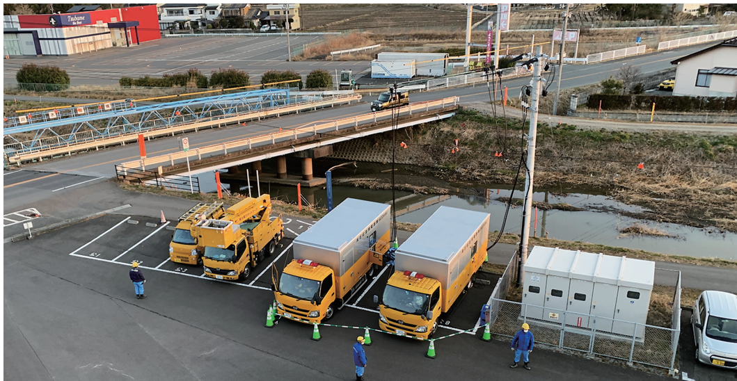
図3 早朝からの電源車による給電活動 2022年3月17日5時55分撮影
