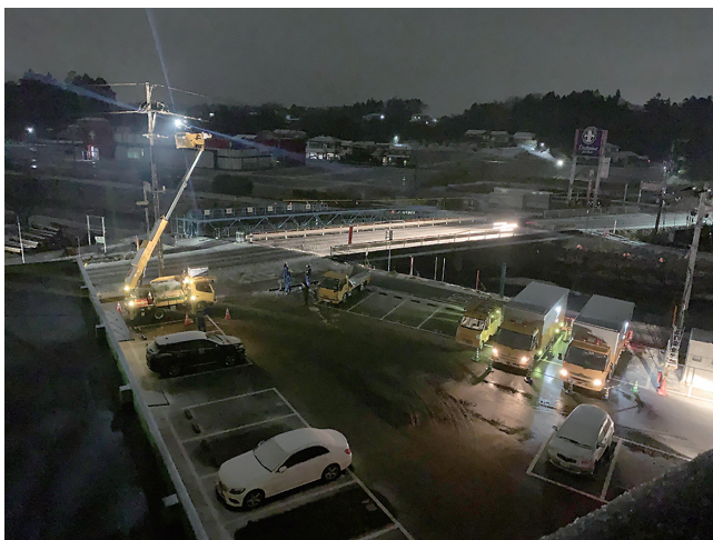
図5 雪の降るなか行われた電力切り替え工事 2022年3月18日20時20分撮影
