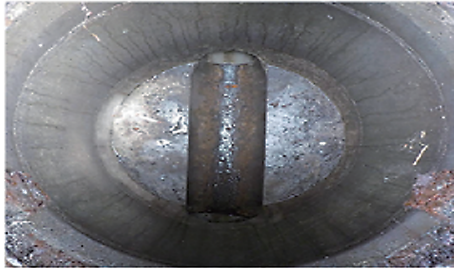
損傷のない汚水ます
